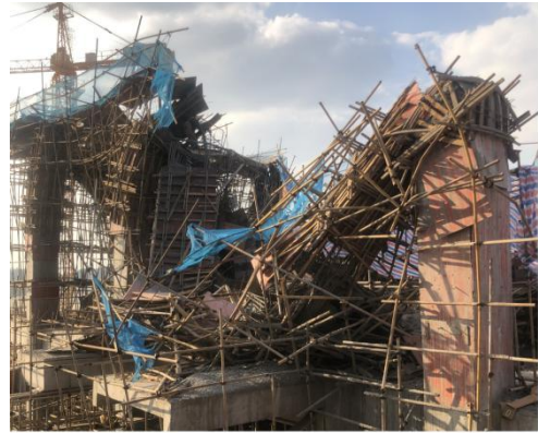
图2 A-B跨整体坍塌
