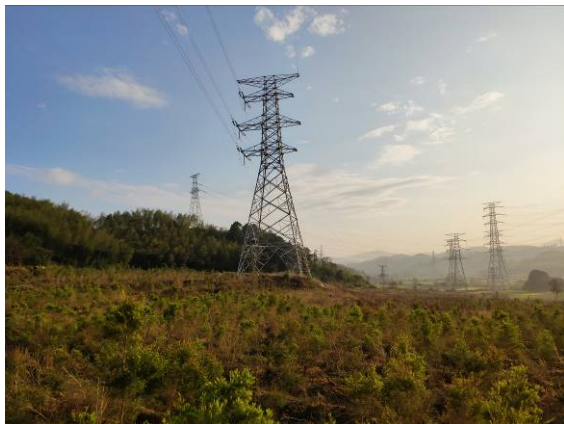
现状220kV增雪线#6塔
