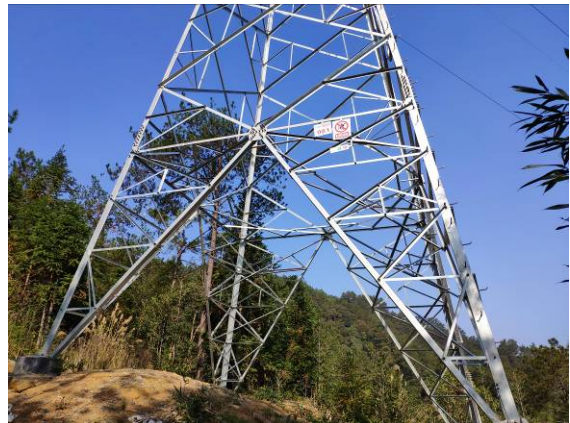
现状220kV增雪线#81塔
